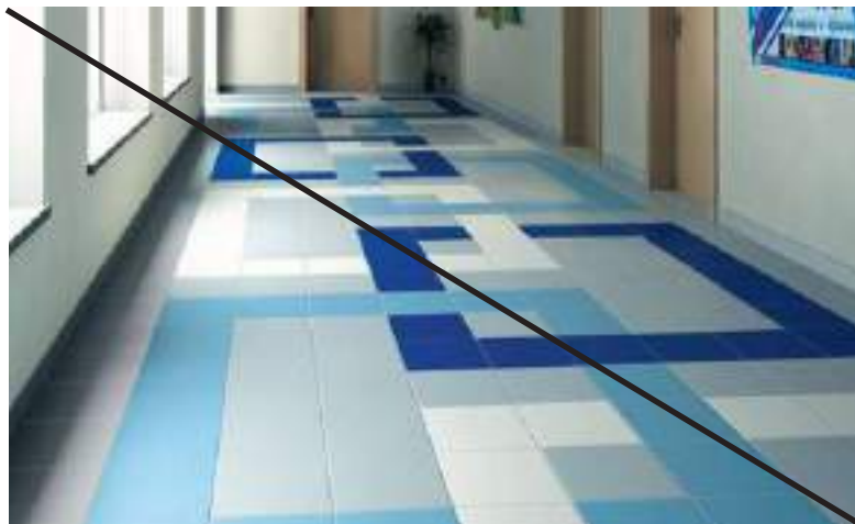
Плохо Цветные вставки из плитки
